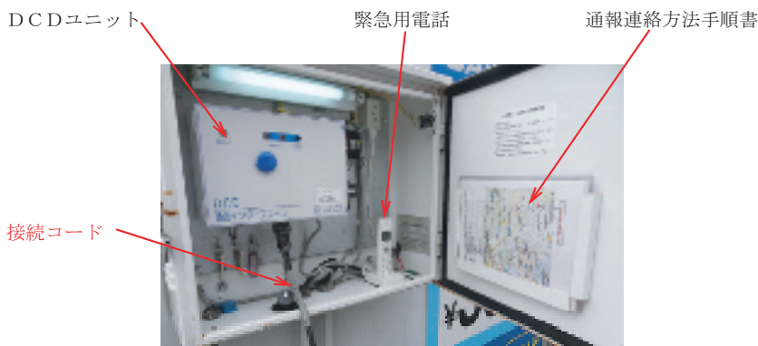
写真2 DCDユニットの設置状況 (例)
