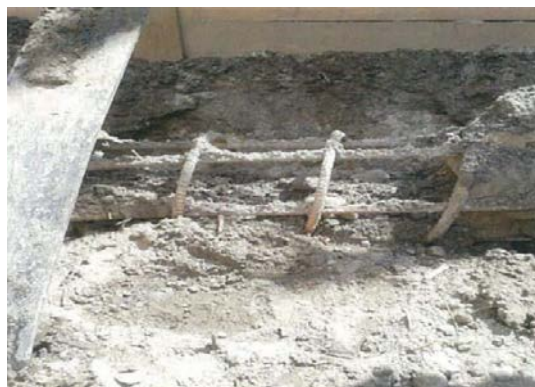
写真 3 支柱の下部の状況
