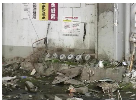
写真 2.2.18 被害のなかった注入口
