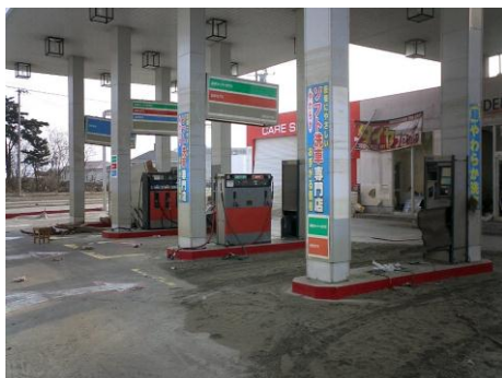
写真 2.2.6 固定給油設備が欠損したアイランド
