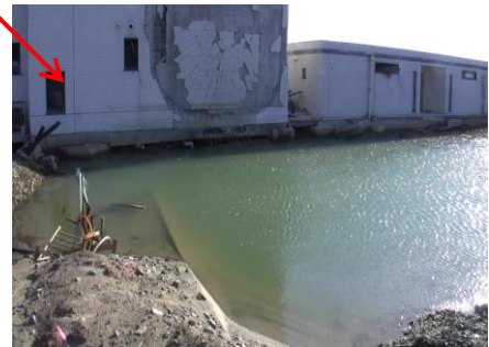
地下タンク貯蔵所 (地下貯蔵タンク流失)
