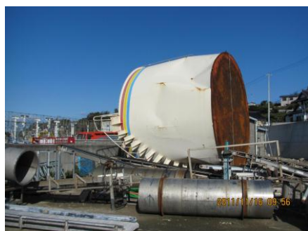
写真 2.1.1 流された屋外貯蔵タンク
