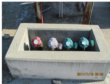
写真 2.2.22 コンクリート枠内設置の注入口
