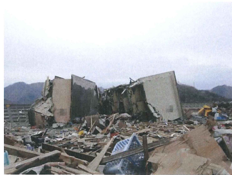
写真6.2.1-8 CB造集合住宅の転倒
