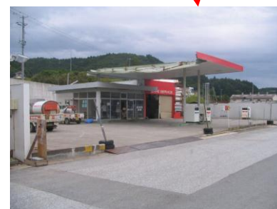
写真 2.3.2 タンクが流された屋外タンク貯蔵所に隣接する給油取扱所（地下貯蔵タンクに被害無し）
