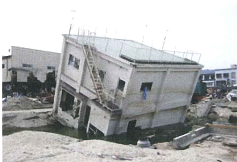
写真6.2.1-10 洗掘による2階建て建築物の傾斜
