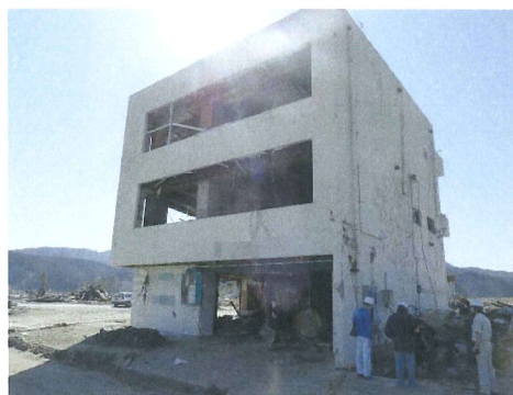
写真6.2.1-3 残存する3階建て建築物
