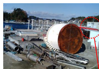
流された屋外貯蔵タンク
