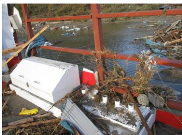
写真 4.2.1 ボックス内設置
