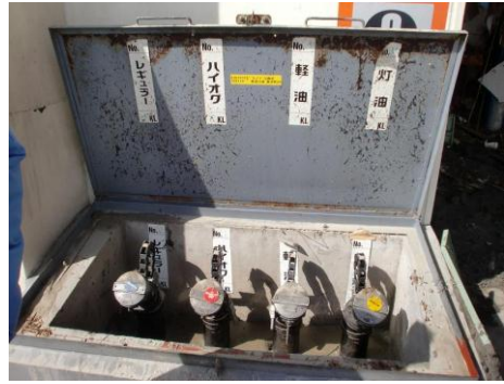
写真 2.2.20 ボックス設置の注入口 (日本ガソリン計量機工業会提供写真)
