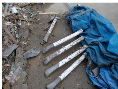
写真 2.2.14 通気管の地面からの折れ曲がり (日本ガソリン計量機工業会提供写真)
