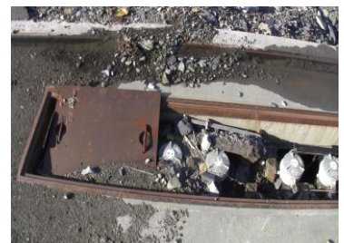
写真 4.2.3 地盤面下設置
