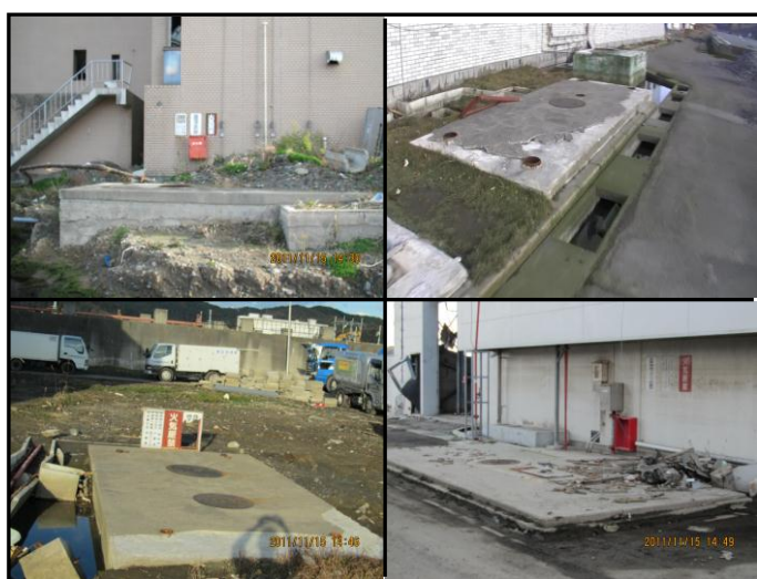
写真 2.3.1 石油基地周辺の地下貯蔵タンク
