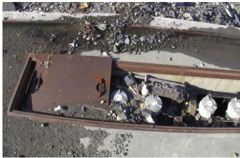
写真 2.2.23 地盤面下設置の注入口
