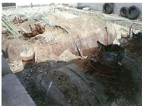
写真 2.2.1 タンク浮上 (上部スラブを取り除いた状態)
