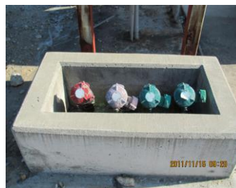
写真 4.2.2 コンクリート枠内設置
