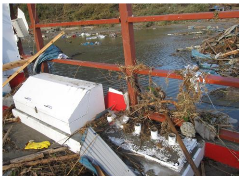
写真 2.2.21 ボックス設置の注入口 (日本ガソリン計量機工業会提供写真)
