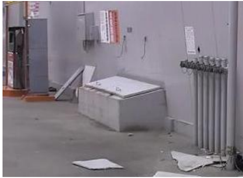
写真 2.2.19 ボックス設置の注入口
