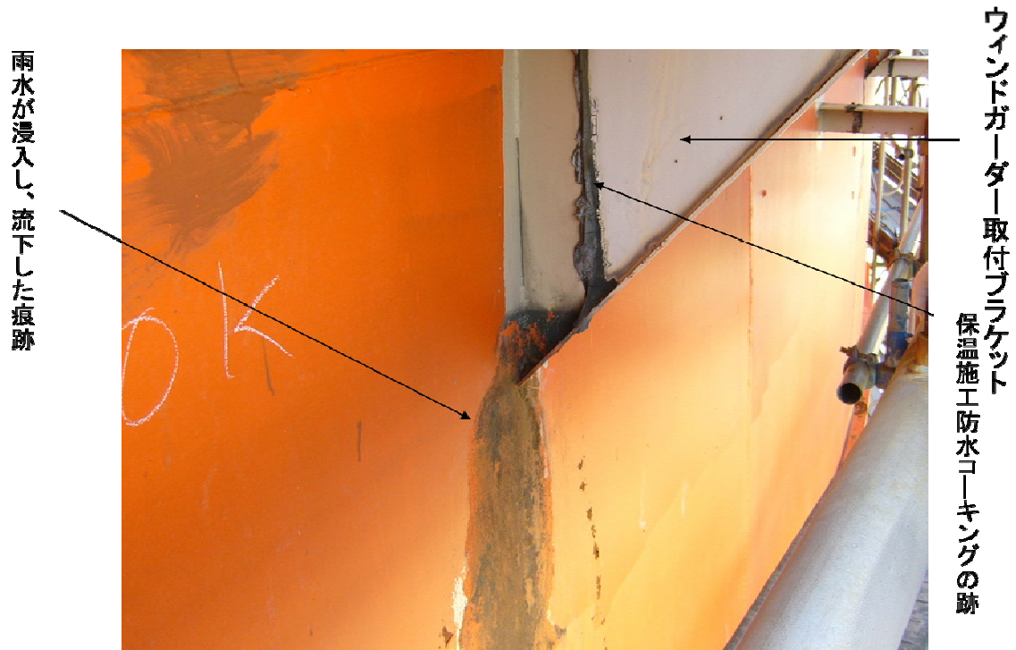
図 3.1-13 ウィンドガーダ取付ブラケット
