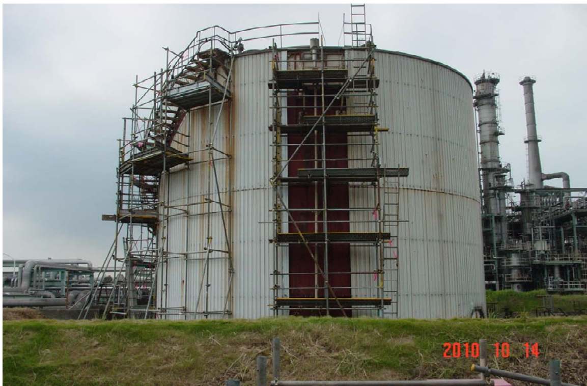
図 3.1-27 泡消火配管立ち上がり部（保温材を撤去して点検実施）
