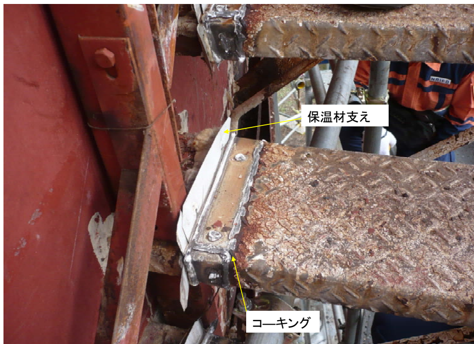
図 3.1-25 階段部の保温施工状況
