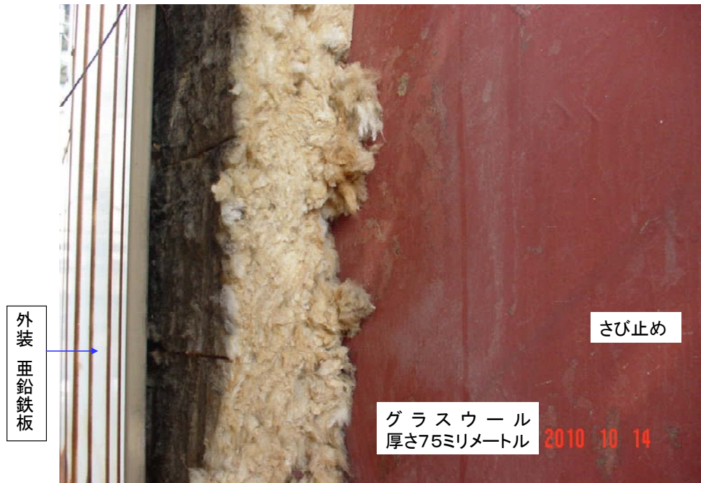
図 3.1-24 保温施工の状況
