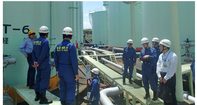
写真8 屋外タンク貯蔵所において現地指導
