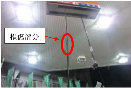
写真1 ノズルNo.5とNo.6を収容するデリベリユニットと損傷した給油ホース 写真2 ノズルNo.5の給油ホース損傷部分
