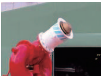
写真 4 ノンアスピレートノズルの例
