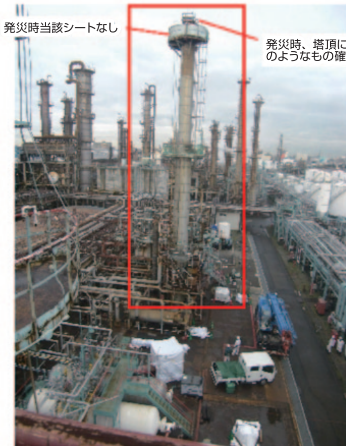
ストリッパー塔外観 (開孔したノズルは塔頂近くのステージ付近)
