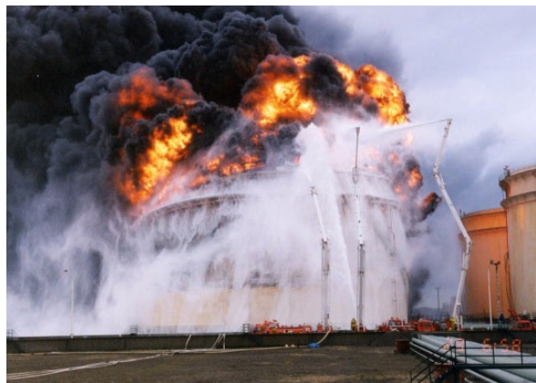
写真2 浮き屋根式屋外貯蔵タンクの全面火災と消火活動の状況（その2）
