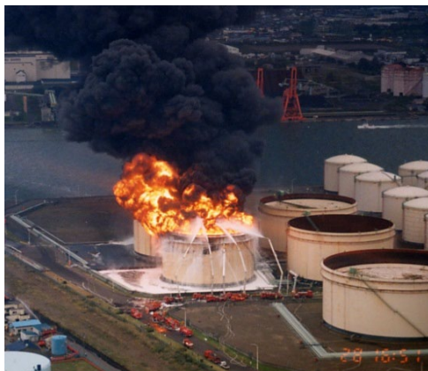
写真1 浮き屋根式屋外貯蔵タンクの全面火災と消火活動の状況（その1）
