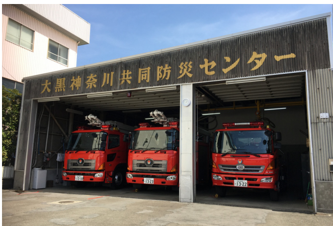
KSP大黒神奈川共同防災センターの拠点
