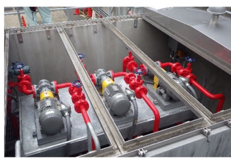
写真4 ポンプ内室状況
