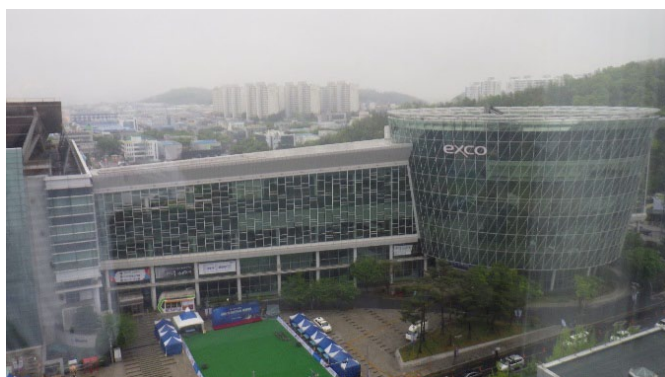
国際消防安全博覧会場の外観
