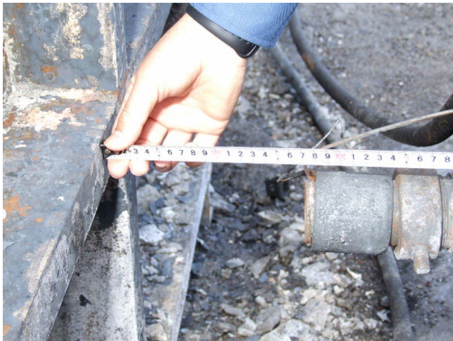
写真15 結合部の間隔の測定
