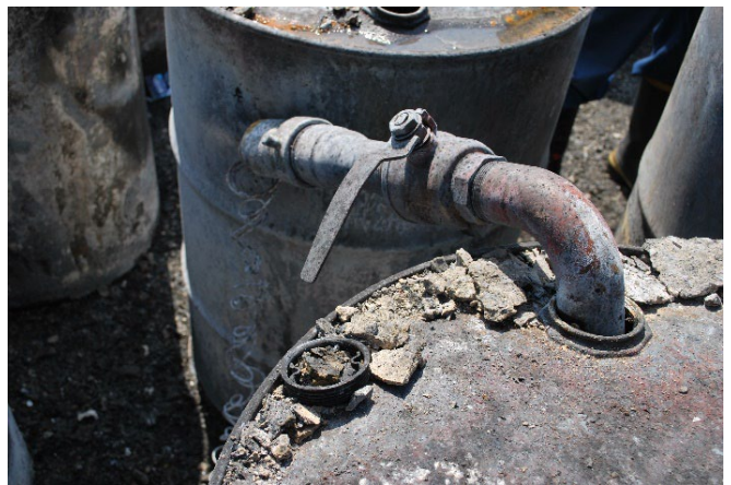
写真11 ドラム容器に刺した吸引ノズル
