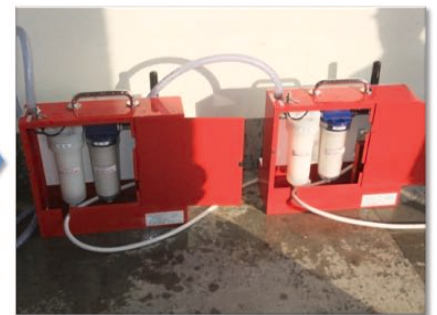
浄水器を飲料水配管へ接続
