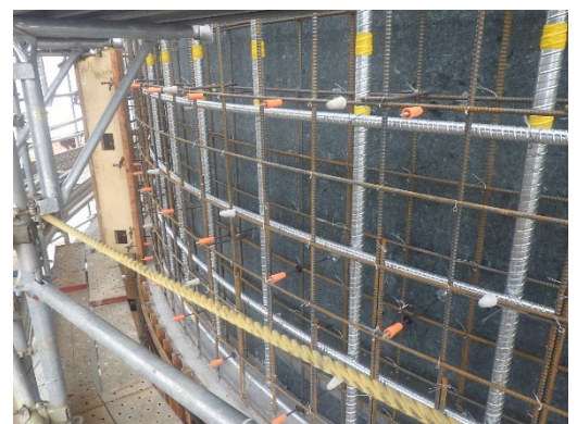
写真-2 PC 鋼材配置
