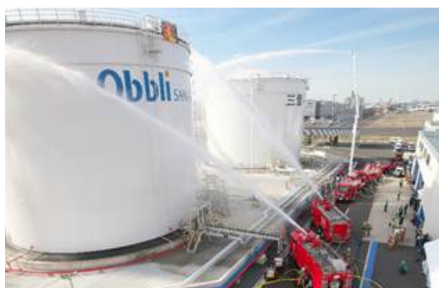
自衛防災組織と消防隊による一斉放水
