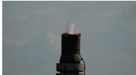
フレアスタック頂部 (30倍ズームカメラ活用(距離約470m))
