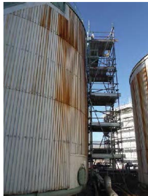
(写真6) 開口部の確保作業全景
