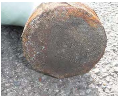
(写真12) 西側通気管引火防止網外側
