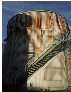
(写真3) タンク本体南側
