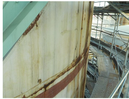
(写真11) 東側階段付近
