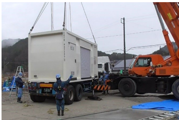
写真 2-1 コンテナ輸送設置
