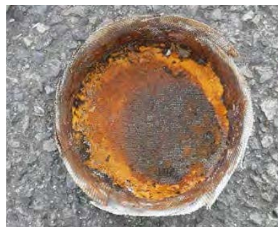
(写真13) 西側通気管引火防止網内側
