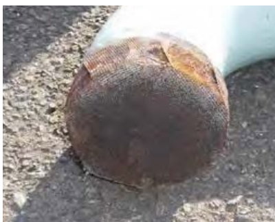
(写真14) 東側通気管引火防止網外側
