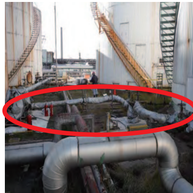
(写真7) 仮設移送配管
