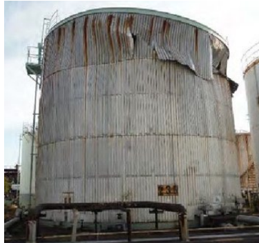
(写真1) タンク本体北側
