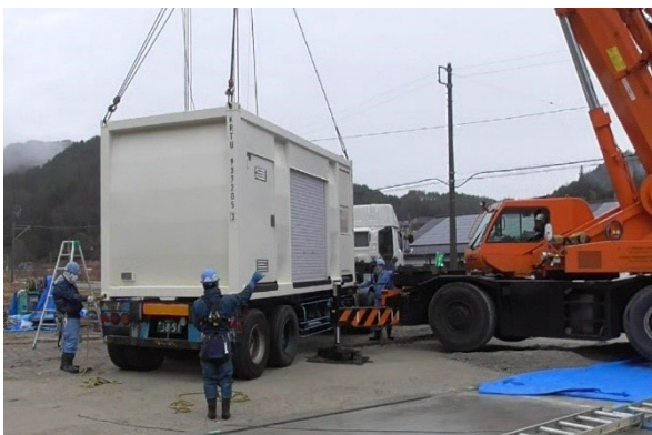
写真 2-1 コンテナ輸送設置
