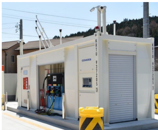
写真 2-2 コンテナ型給油所20ft レギュラー (9kℓ) ハイオク (3.5kℓ) 軽油 (5.3kℓ)
