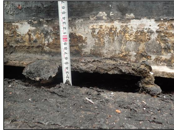
写真9 事故タンク底板の浮きの状況
