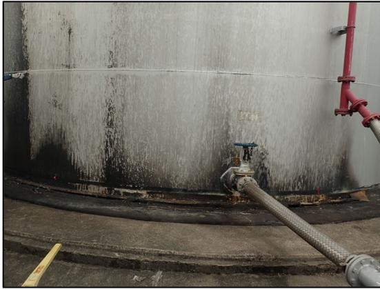
写真8 事故タンク外面の焼損状況
