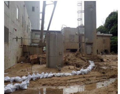
〈写真3〉 土砂流入による被害
