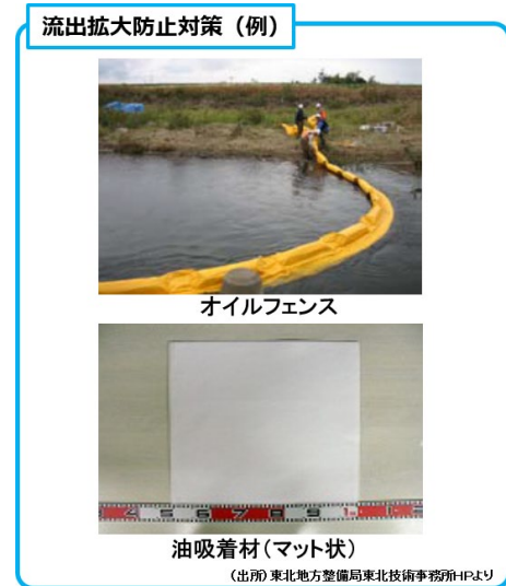
〈写真5〉 流出拡大防止対策 (例)
