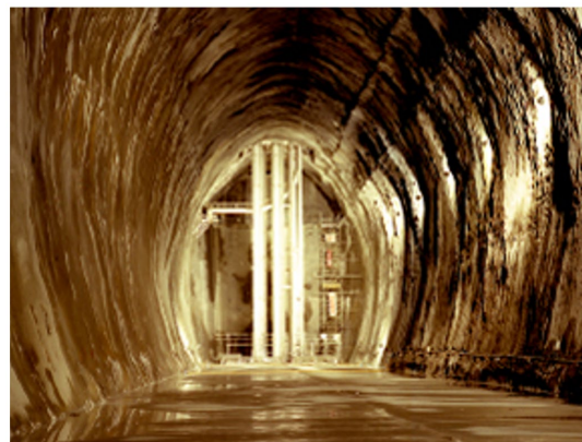
写真.1 岩盤タンクの内部
