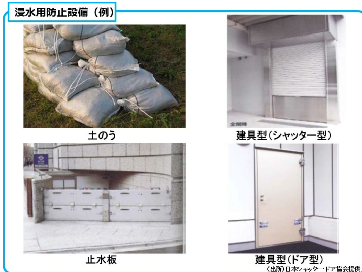
〈写真4〉 浸水防止設備 (例)
