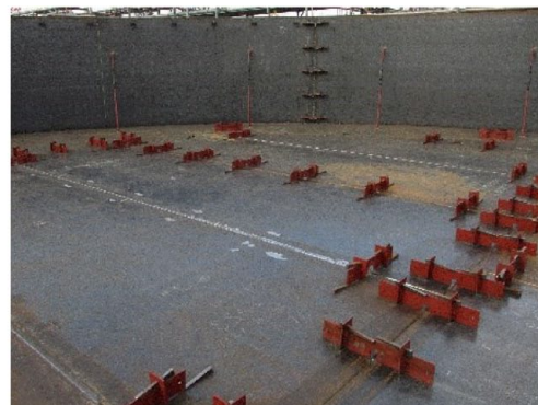
底板及び側板最下段の配列の見学
