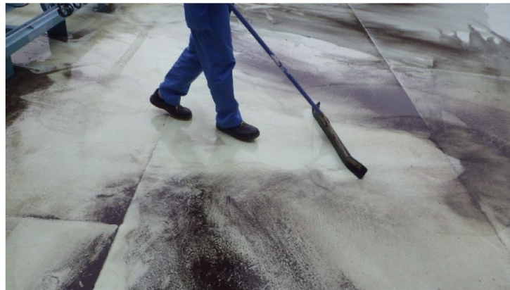
写真－3 デッキ板の目視検査の様子
