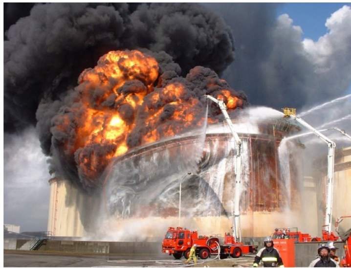
写真-1 浮き屋根式タンクの全面火災
