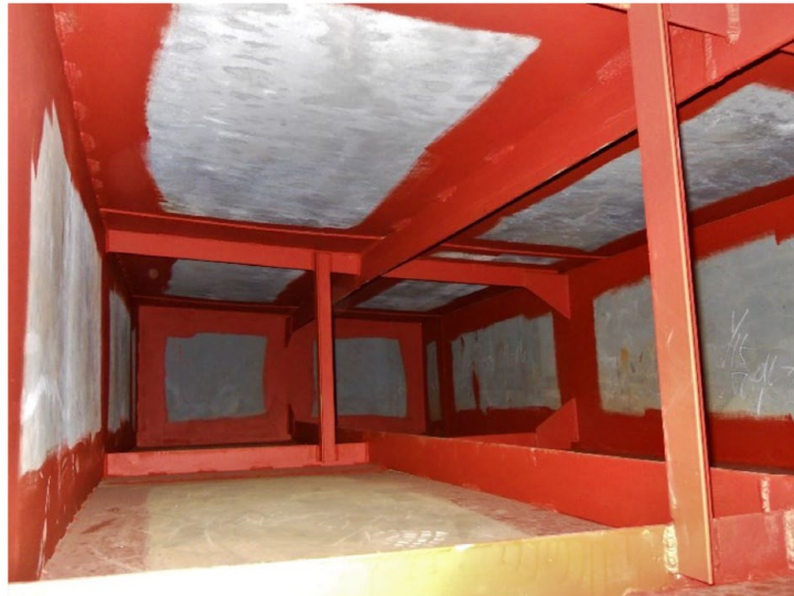
写真-5 ポンツーン内部に配置された骨材の例
