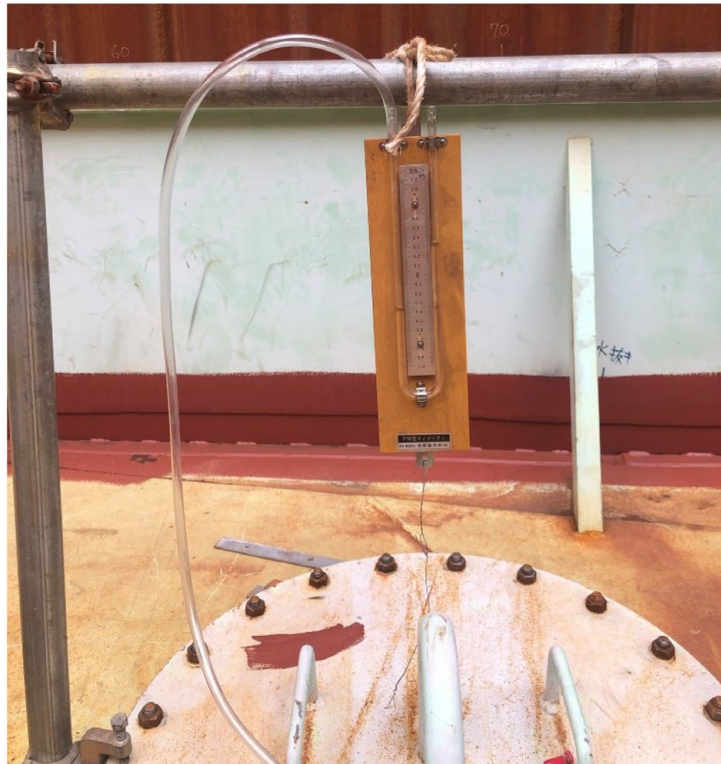
写真-6 マノメーターを用いた加圧漏れ試験の様子
