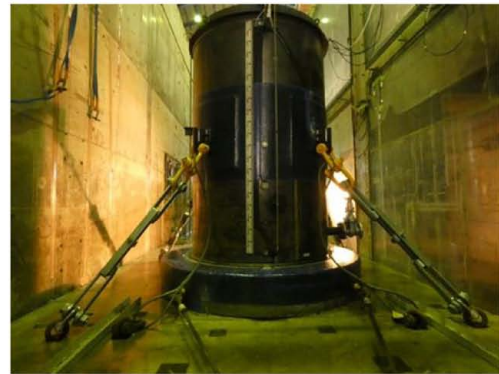
図7 対策工法2 設置状況
