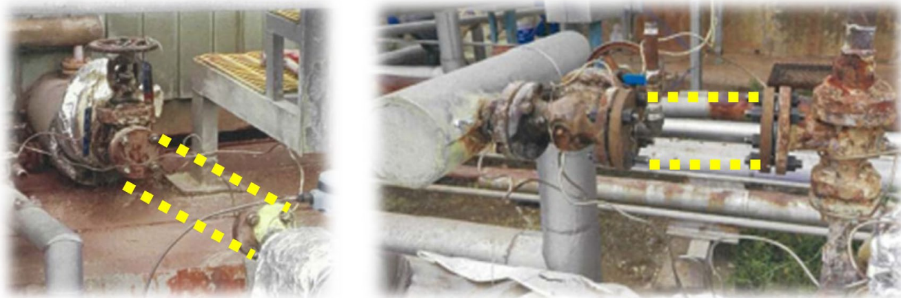
配管縁切りの様子
