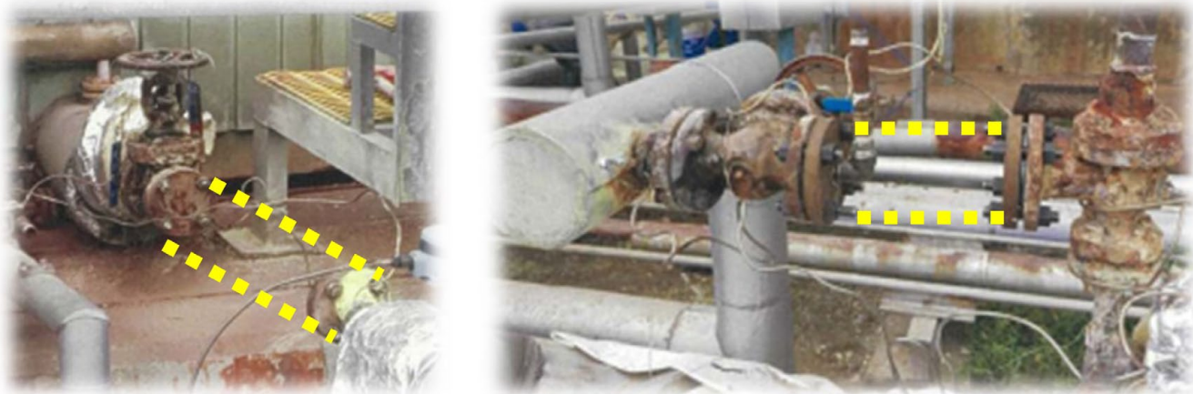
配管縁切りの様子
