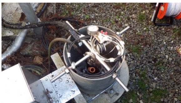
図10 地下水位観測孔の孔口
