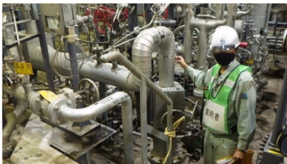
図24 検査対象配管の確認
