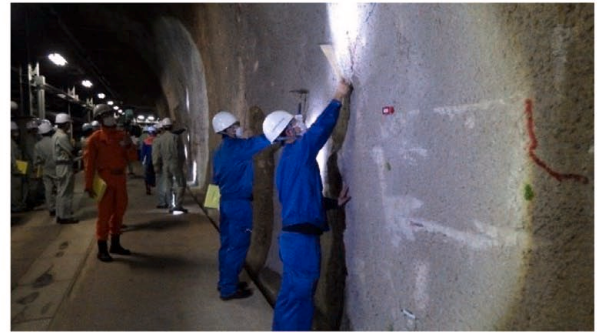
図20 サービストンネル壁面の打音確認
