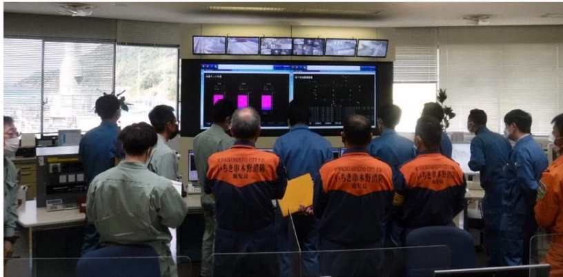
図5 中央計器室における運転状態の確認(※紺の作業服がKHK 検査員)
