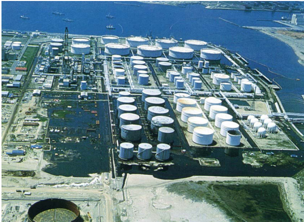
図3 1978年宮城県沖地震の際の仙台市内の製油所における重油の大量流出 (河北新報社撮影)
