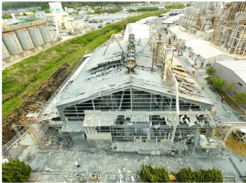
亜鉛末工場の焼損状況
