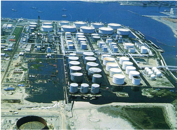
図3 1978年宮城県沖地震の際の仙台市内の製油所における重油の大量流出 (河北新報社撮影)
