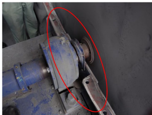
分級ファンシャフト貫通部
