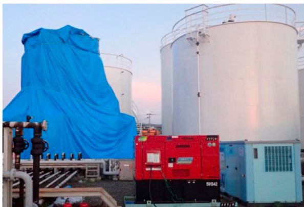
図.6 タンクの養生とエアコン設置
