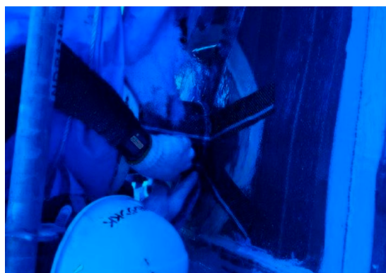
図.12 ノズル部等不連続部へのCFRP貼付け
