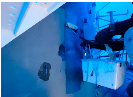
図.8 ケレン後にプライマーを塗布
