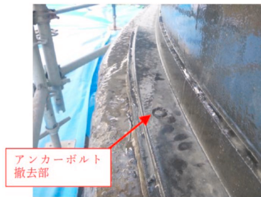
図.7 既存アンカーボルトの撤去
