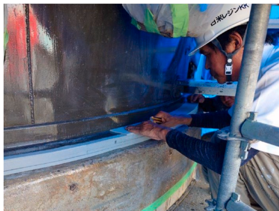
図.9 隅角部へのスペーサーの設置
