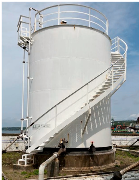
図.1 施工前のタンクの状況 90kL ガソリントank
