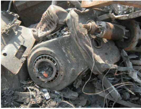
写真12 焼損した発動発電機
