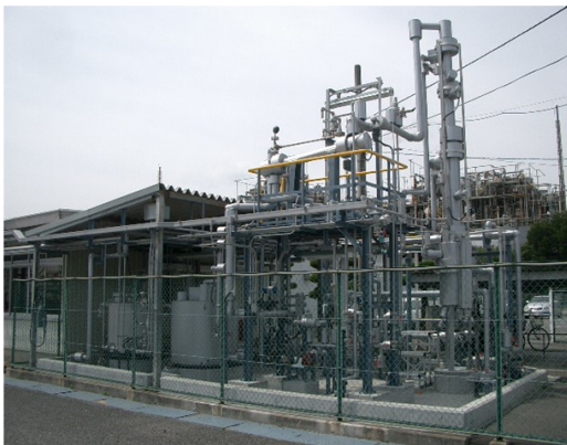
蒸留実習設備全景
