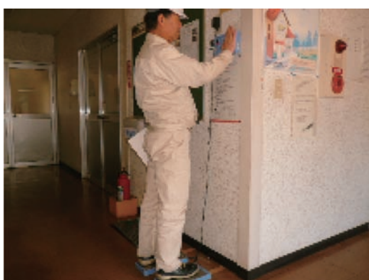
写真8 チェッカーによる作業員の導通チェック（毎朝、全員）
